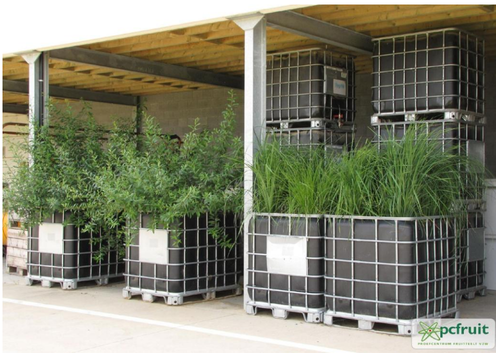
Foto 6: Twee Biofilters (stapels achtergrond) met elk twee bakken voor extra verdamping (wilg links, siergras rechts). Bron: Proefcentrum Fruitteelt vzw
