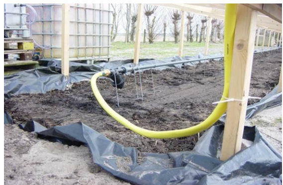
Foto 15 en 16: Fytobac gevuld met Biomix 'bak' van vijverfolie in de grond (locatie: Loonbedrijf in Noord-Holland)
