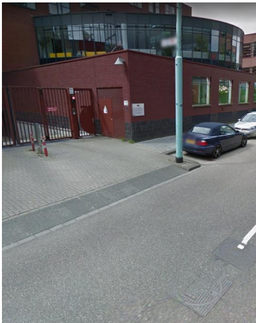
15: trafo Liander elektra (in pandig)
