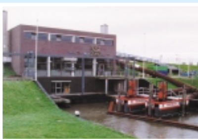
Boezemgemaal Westland wordt sinds begin 2000 bijgestaan door enkele noodpompen. Tijdens het noodweer van november 2000 hebben deze erger voorkomen. In 2001 wordt de capaciteit van het gemaal definitief verdrievoudigd.
