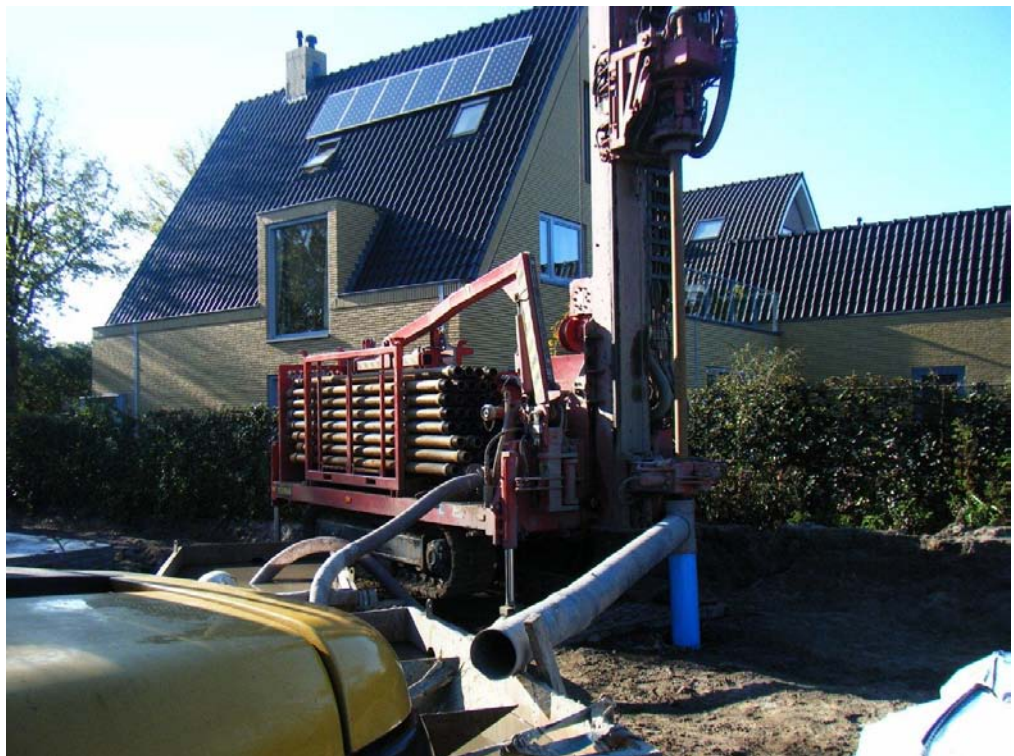
De installatie van een WKO-systeem in de praktijk.
