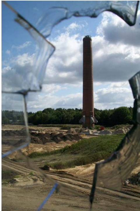
Enka terrein: grootschalige bodemsanering vindt nog steeds plaats
