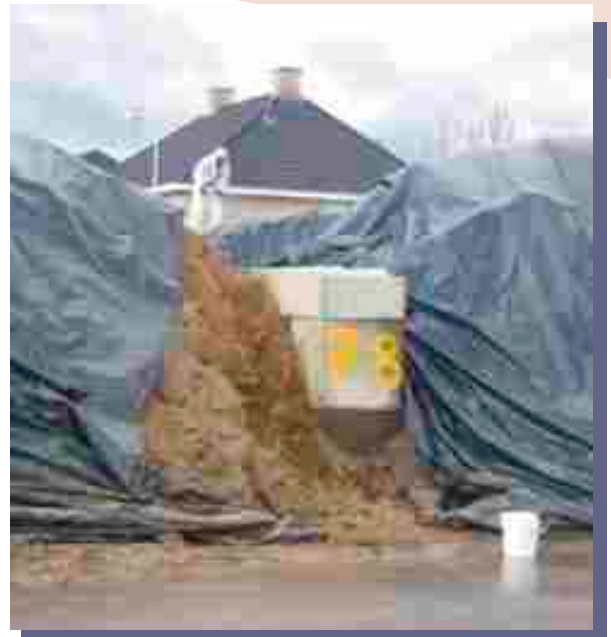
Foto: Depotonderzoek asbestgrond in woonwijk De Hogenkamp te Goor (bron Lankelma Ingenieursbureau).
