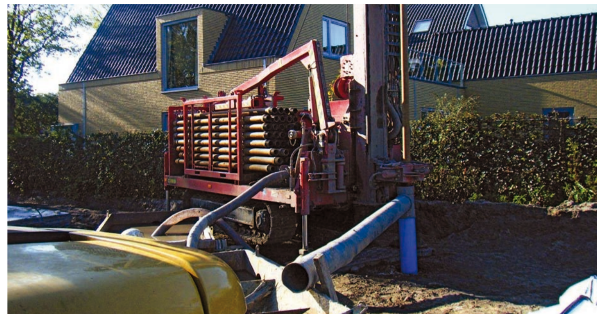
Aanleg van een bodemenergiesysteem.
